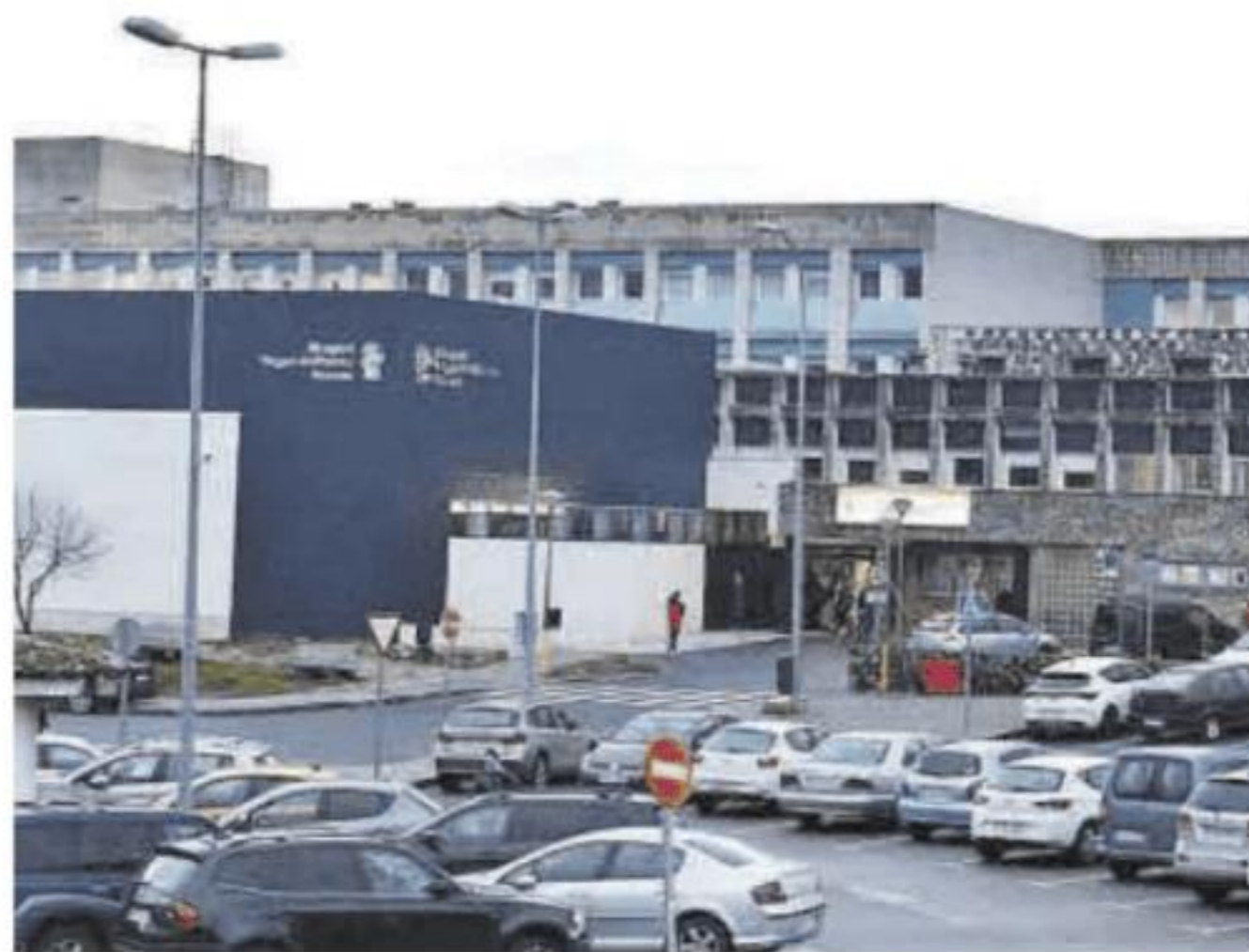
Hospital de Plasencia, con el búnker de radioterapia.
