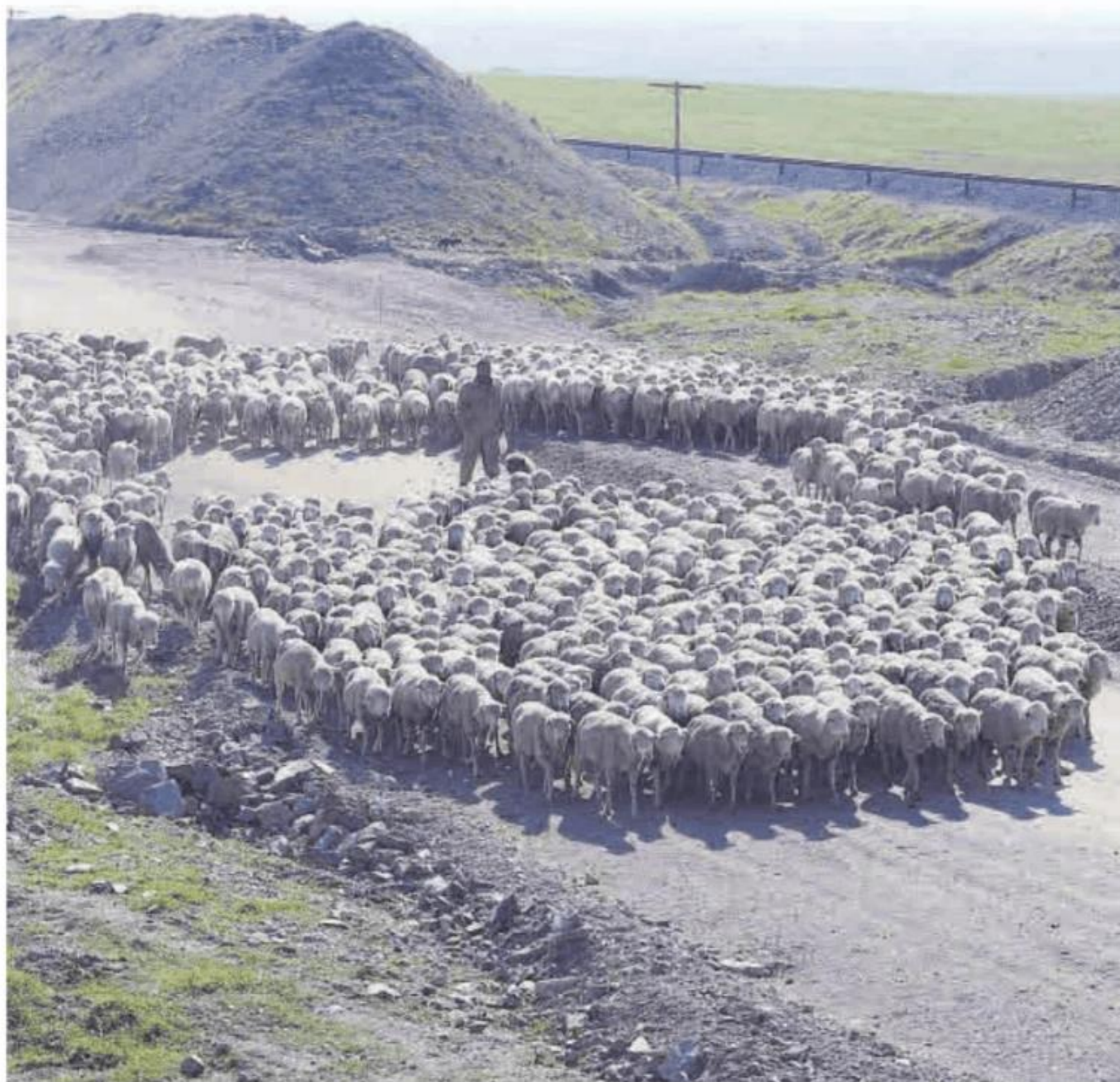
Un pastor y sus ovejas pasan junto a un tramo en obras de la futura línea del AVE cerca de Cáceres.
