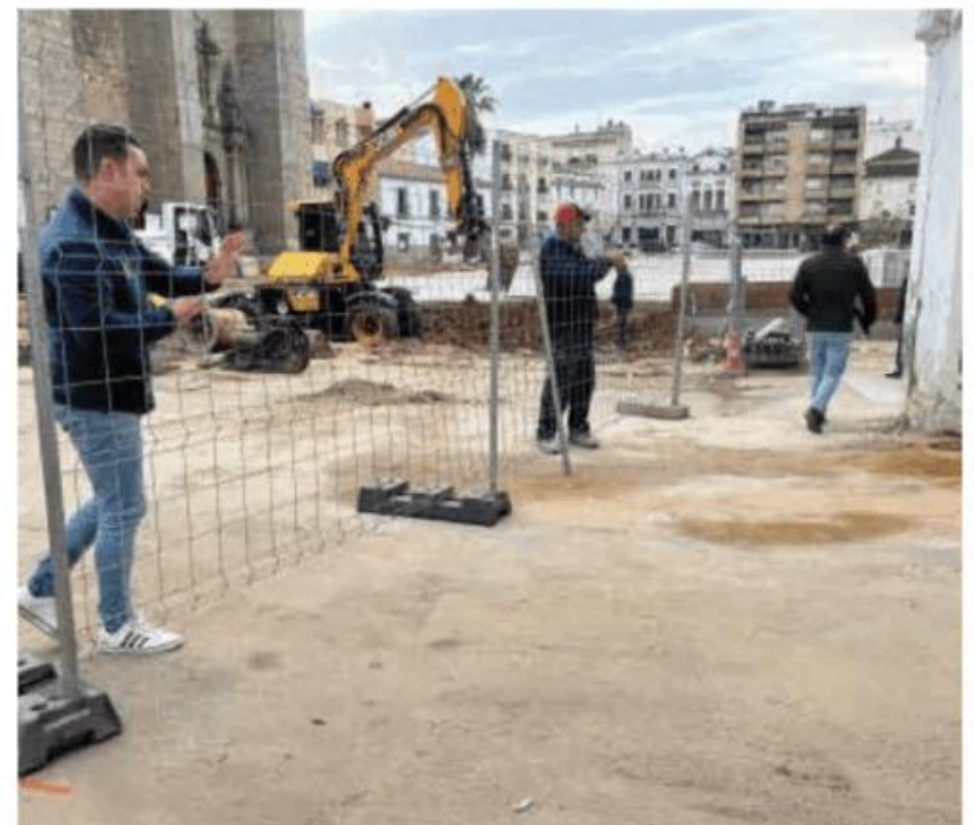
Trabajos de mejora del saneamiento en el solar de Banesto.
